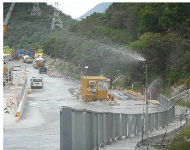
以自動灑水方式抑制塵埃產生
