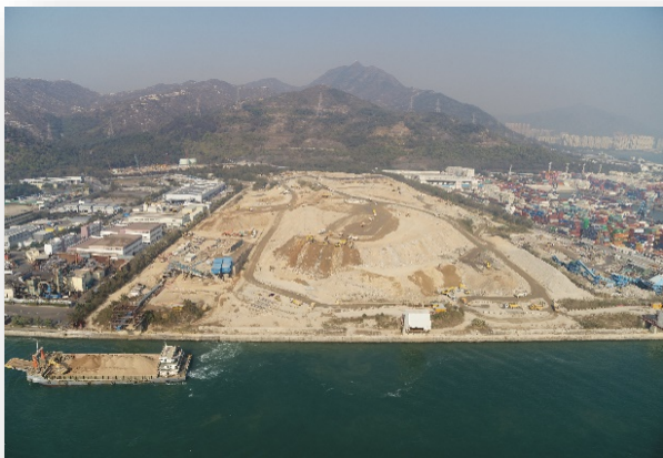
屯門第38區填料庫 Tuen Mun Area 38 Fill Bank
